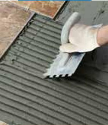
Aplique el mortero en una sola dirección con el lado dentado de la llana
