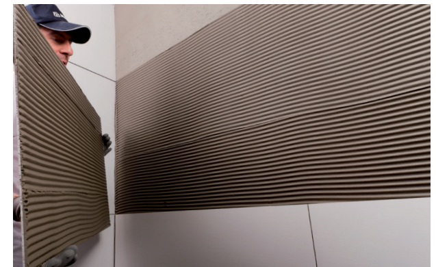
Colocación de baldosa fina sobre pared
