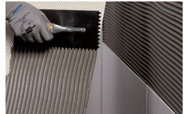
Aplicación de Ultralite S2 sobre el dorso de la baldosa
