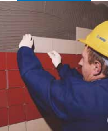
Colocación parcial de cerámica desde arriba hacia abajo
